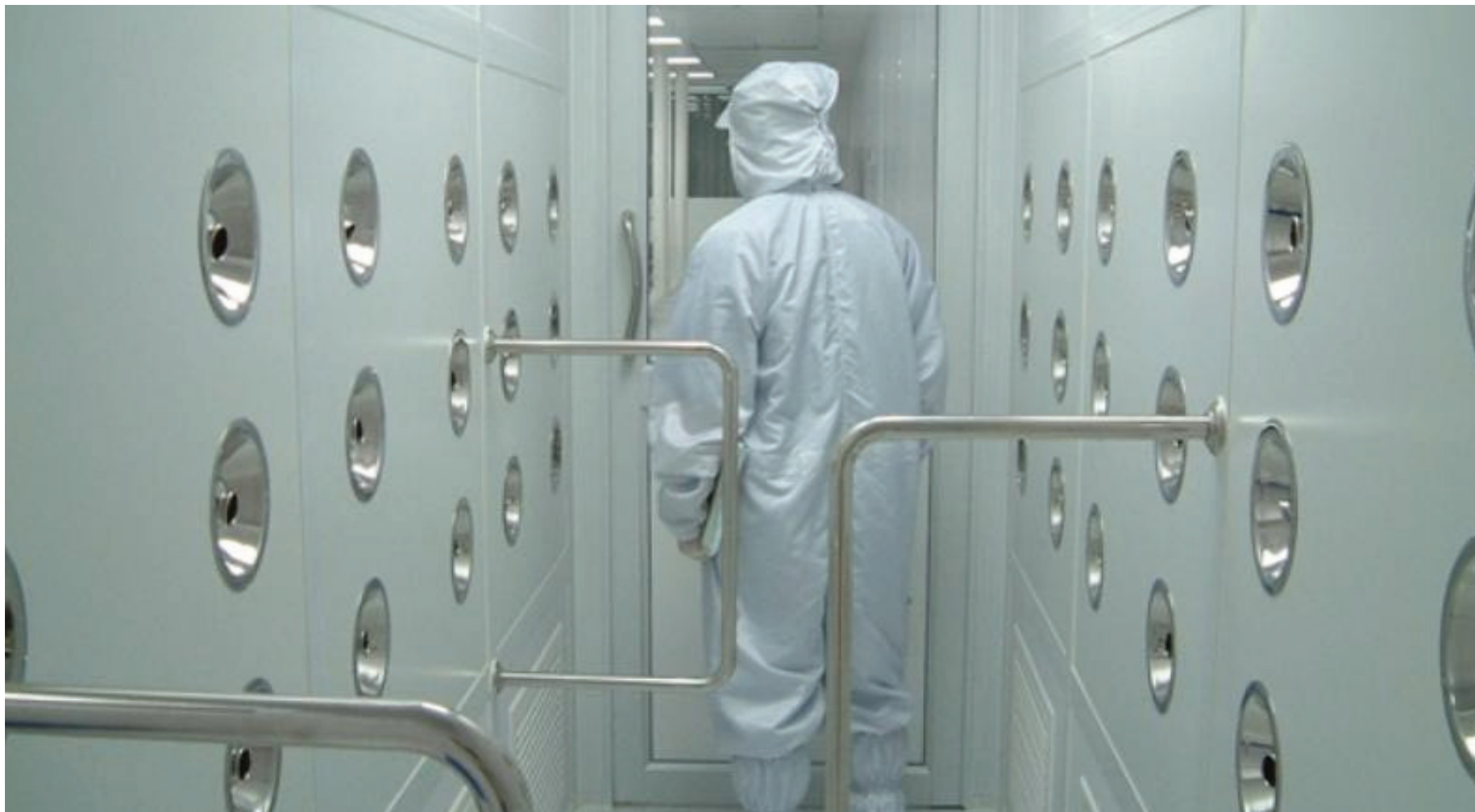
无尘室施工实录
