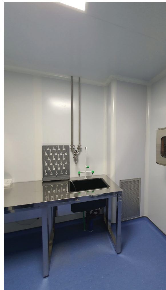
无尘室施工实录
